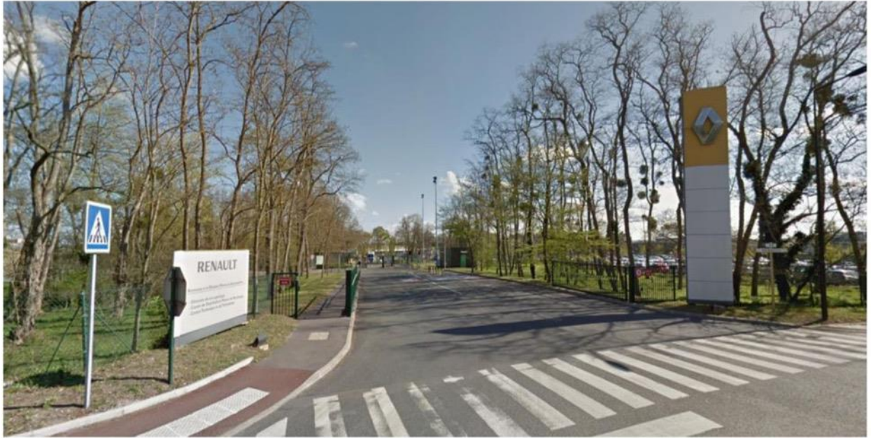
Photo 1 – Entrée du site de projet par l'avenue du gros chêne
